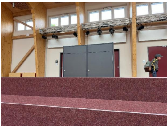
Technik (GS) im Atrium
